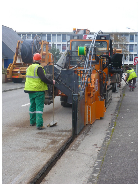
Chantier de génie civil allégé (photo CETE de l'Ouest)
