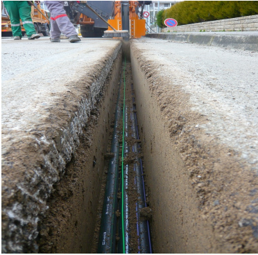
Mini-tranchée (photo CETE de l'Ouest)
